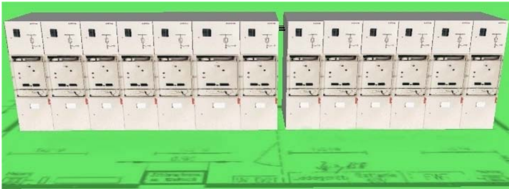
Abbildung 7.11: 13-feldrige 12 kV-Übergabestation (3D-Ansicht)
